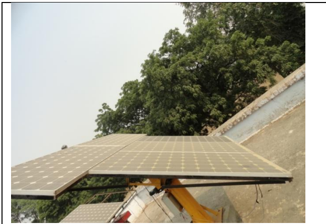
FIG 4: ACTUAL SOLAR TRACKING SYSTEM (170X5 WATT)
